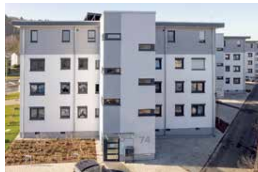
Vorher: Braunfelser Straße 74, Wetzlar / Nachher: Braunfelser Straße 74, Wetzlar (energetische Sanierung, Aufstellung eines neuen Treppenhausturms sowie Einbau einer Liftanlage, Aufstockung des Gebäudes um ein weiteres Staffelgeschoss)
